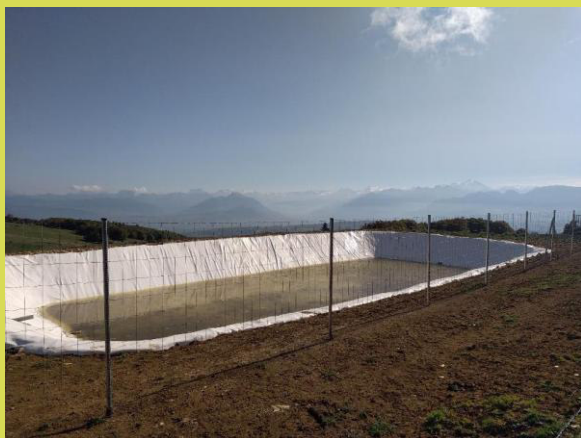
Eau mutualisée : colonne de distribution de 3km desservant 5 alpages
