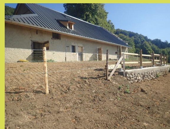
Travaux de conservation de bâtiment (Les Convers, Presilly)
