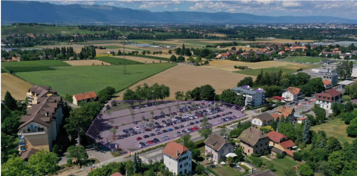
Photographie aérienne du parking P+R de Perly vue depuis le Sud (photographie antérieure à 2023)
