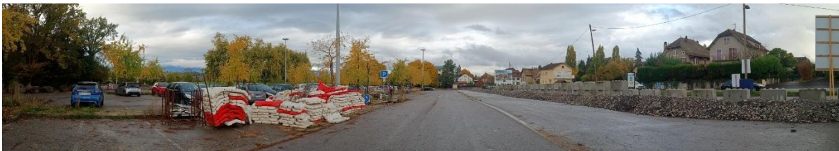
Photographie du parking relais P+R de Perly (octobre 2025)
