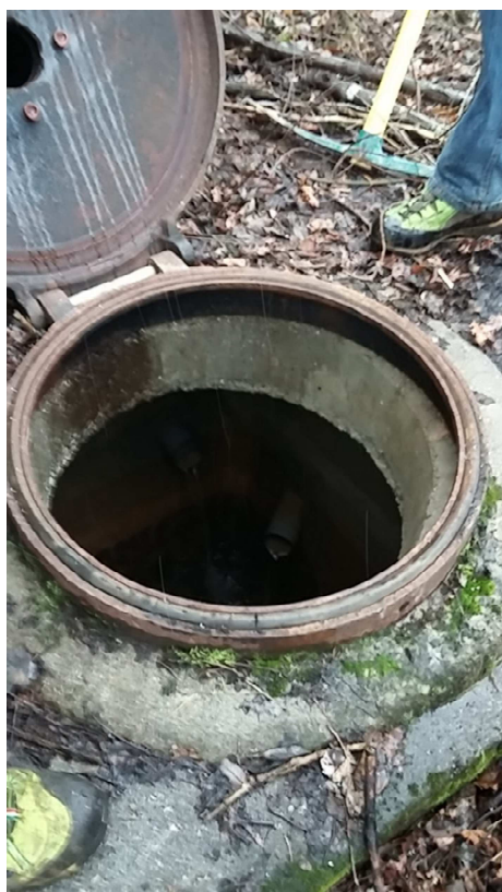
Vue de la chambre de réunion
