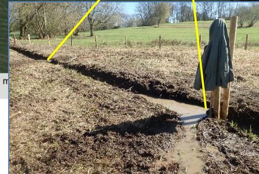
Renvois d'eau dans le drain alimentant en eau la zone humide
