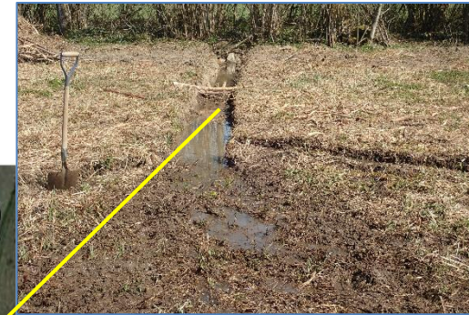
Renvoi d'eau du drain Nord
