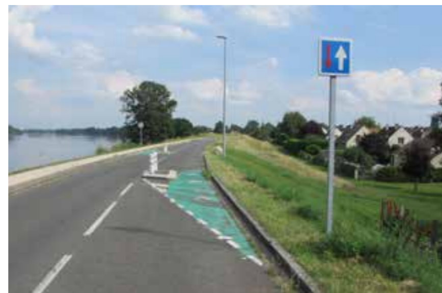
Écluse sur véloroute visant à ralentir le trafic et sécuriser les cyclistes
