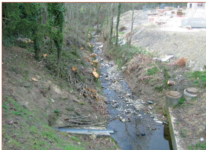
La Vosognette après les travaux d'entretien.
