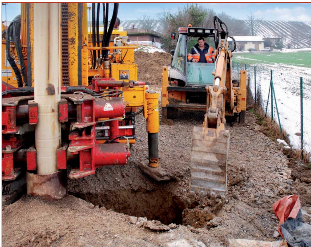
Travaux pour la réalisation de deux forages supplémentaires à Crache ( St-Julien).
